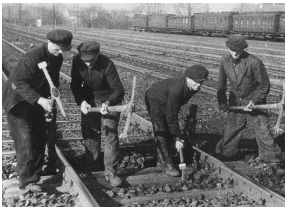
42. Zdeněk Tmej, Podbíjení pražců ze souboru Totální nasazení , 1942–1943
